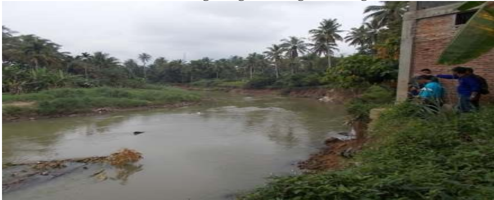
Gambar 2. Keadaan Tebing Sungai Batang Lembang Di Kota Solok
