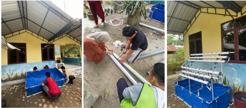
Gambar 4. Proses pembuatan kolam terpal. A. Pemasangan kolam terpal; B. Pemotongan pipa akuaponik; C. Tampilan kolam terpal
