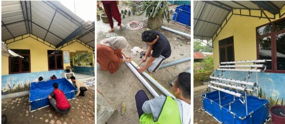
Gambar 4. Proses pembuatan kolam terpal. A. Pemasangan kolam terpal; B. Pemotongan pipa akuaponik; C. Tampilan kolam terpal
