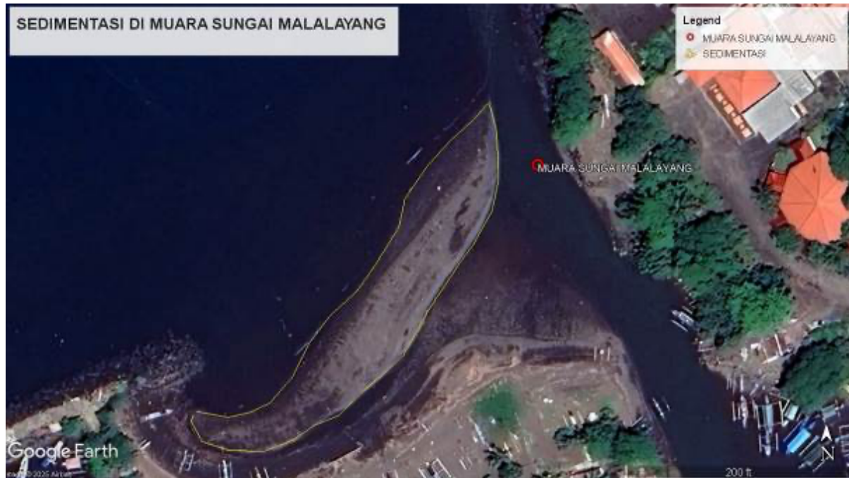
Gambar 10. Kondisi Sedimentasi Eksisting
