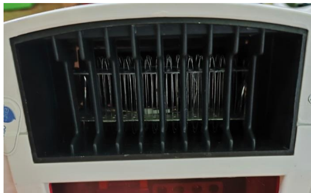
Gambar 5. Pemasangan Heater (Sumber: Dokumen Pribadi, 2024)
