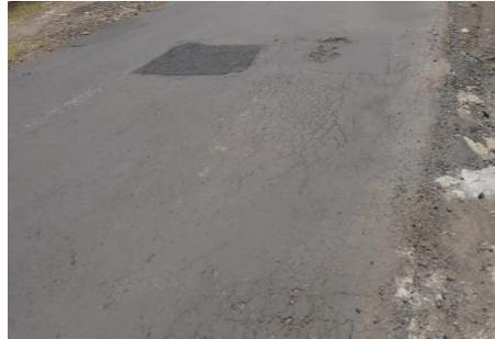
Gambar 3 Retak kulit buaya (*Alligator Cracking*) di ruas jalan Weleri – Patean
