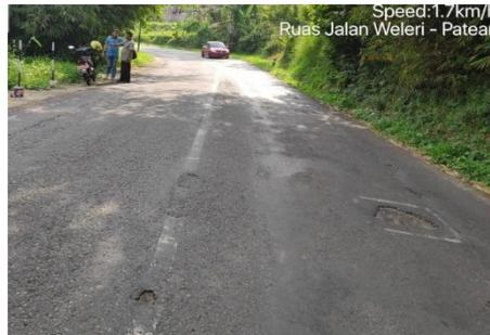
Gambar 6 Lubang (*Potholes*) di ruas jalan Weleri – Patean
