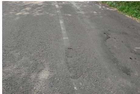
Gambar 4 Retak selip (*Slippage Cracking*) di ruas jalan Weleri – Patean
