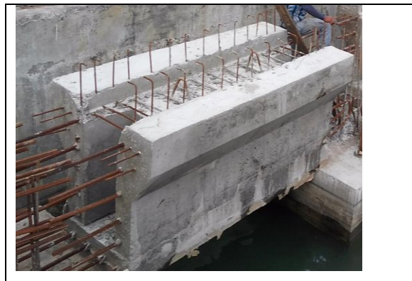
Gambar 7. Balok Pracetak yang telah dipasang
