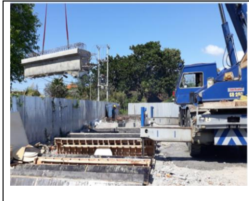
Gambar 4. Pengangkatan Balok Dari Bekisting
