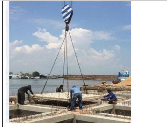
Gambar 9. Pemasangan Pelat umur 7 hari
