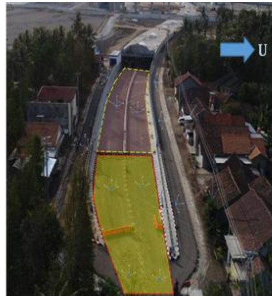
Gambar 5. Area pengaliran Underpass YIA sisi timur (arah Yogyakarta)
