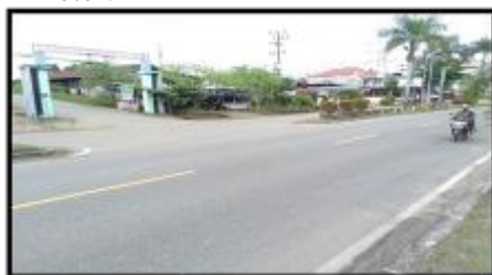
Gambar 12 Peletakan bukaan median yang salah
