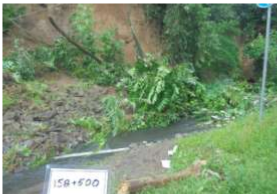
Gambar 7. Kelongsoran di titik STA 158 + 500
