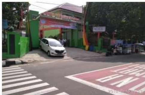
(b) SMPN 3 Padang Panjang Jalan Jenderal Ahmad Yani
